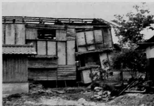
写真4 塩屋部落、断層による帯状陥没上の民家 民家が軒並みに破壊、道路の一つへだてた片側は被害なし
