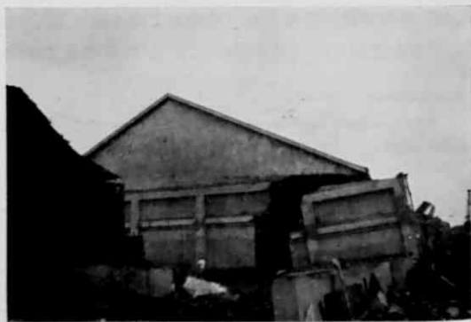
写真7 中央埠頭、日肥運送倉庫 岸壁上の右半分を残して、左側の地盤が移動沈下した
