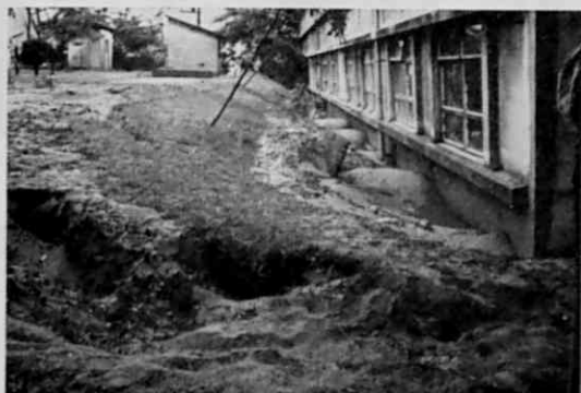
写真 9 川岸町アパート1号棟の噴砂
