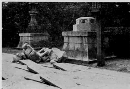
写真1 倒れた灯籠と残った灯籠が加速度の程度を示す……白山神社境内
