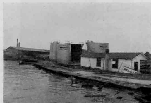
第 3・10 図 倒壊した岸壁と傾斜した石油タンク
