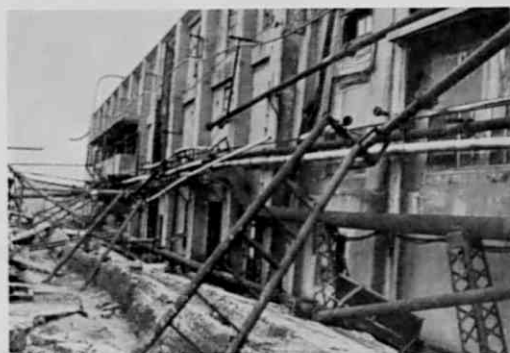
第 3.1 図 建物は傾斜し、配管の支柱は倒れている
