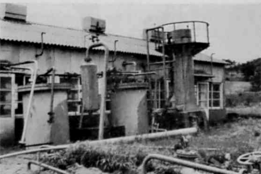
第4・16図 中小型塔槽類の傾斜、手前はガス井の頭
