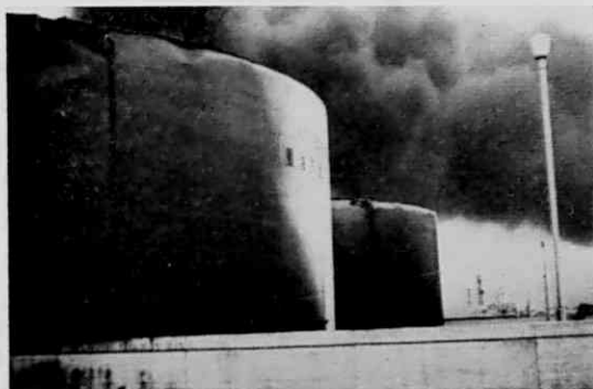
第 4・6 図 重油タンクの液面共振による溢流の例
