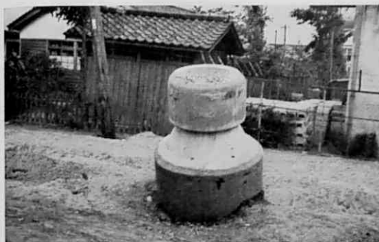
第 4・1 図 軽い物体の浮き上がった例, マンホール (川岸町)
