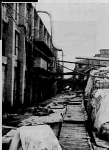
第4・11図 ピットの浮上、パイプの切断の例 (4.3節参照)
