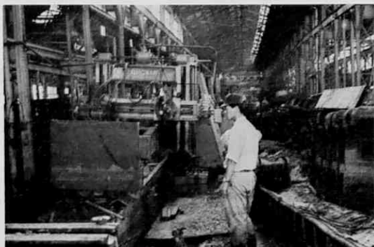
第 4・5 図 工作機械の沈下と土砂の侵入例 クレーン・レールがうねっている
