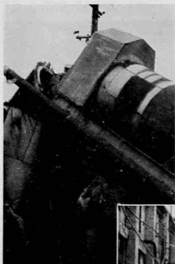
第4・9図 ガス・ホルダの損傷、ガイドの位置が回転している
