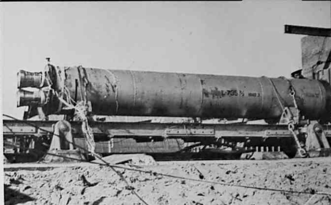
↑ 735 \frac{3}{8} エンジン 735 \frac{3}{8} エンジンに先立って37年4月に秋田実験場 で試験された.
