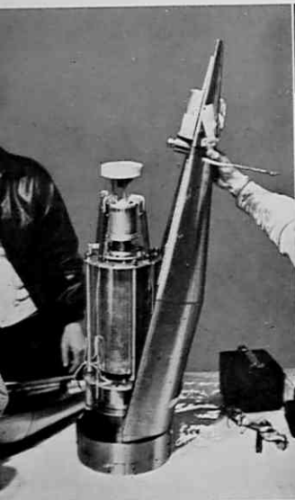
↓ 宇宙線測定器 異なった材質、厚味のケースに収めた3本のガイガー計数管が使われた。 (K-8-11).
