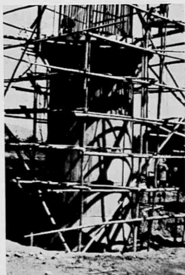
写真1 支塔コンクリートの施工
