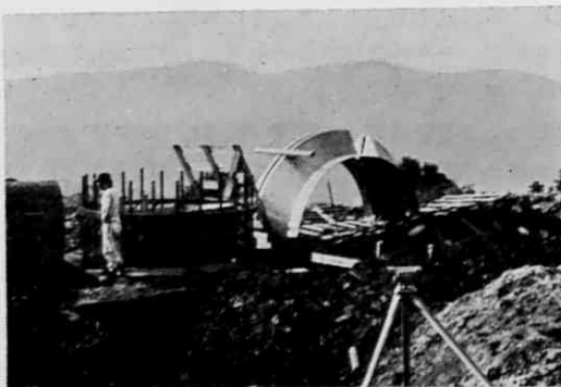
写真2 アンテナ固定装置取付用アンカーボルトとカラー鋼板
