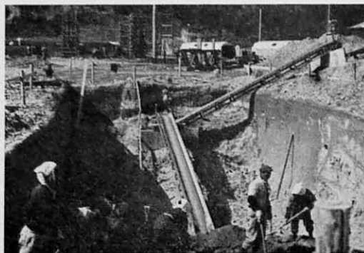
写真5 ロケット誘導路火焔壕床掘工
