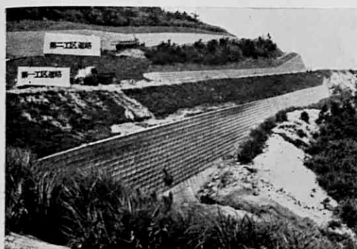
写真3 法留ブロック積
