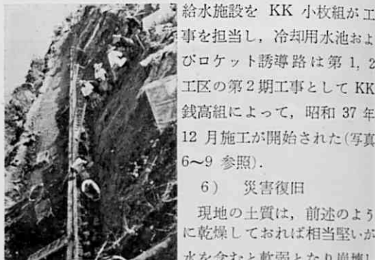
写真9 ブロック積工
