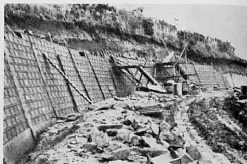
写真8 ブロック積工
