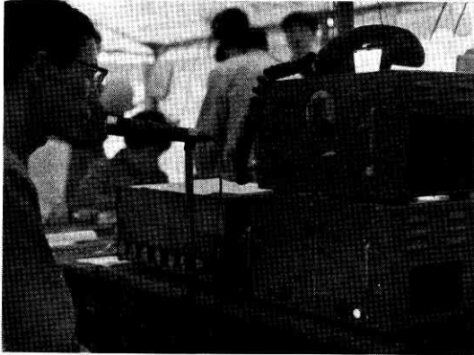
通信本部の通信設備
