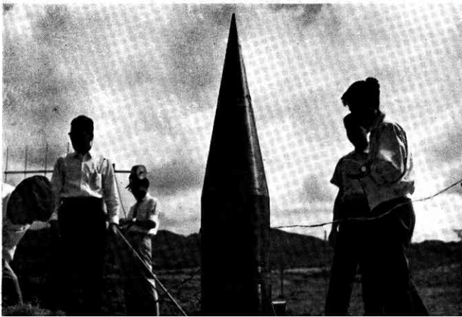
↓ 8型のノーズコーン開頭部の地上試験 (8型5号機)
