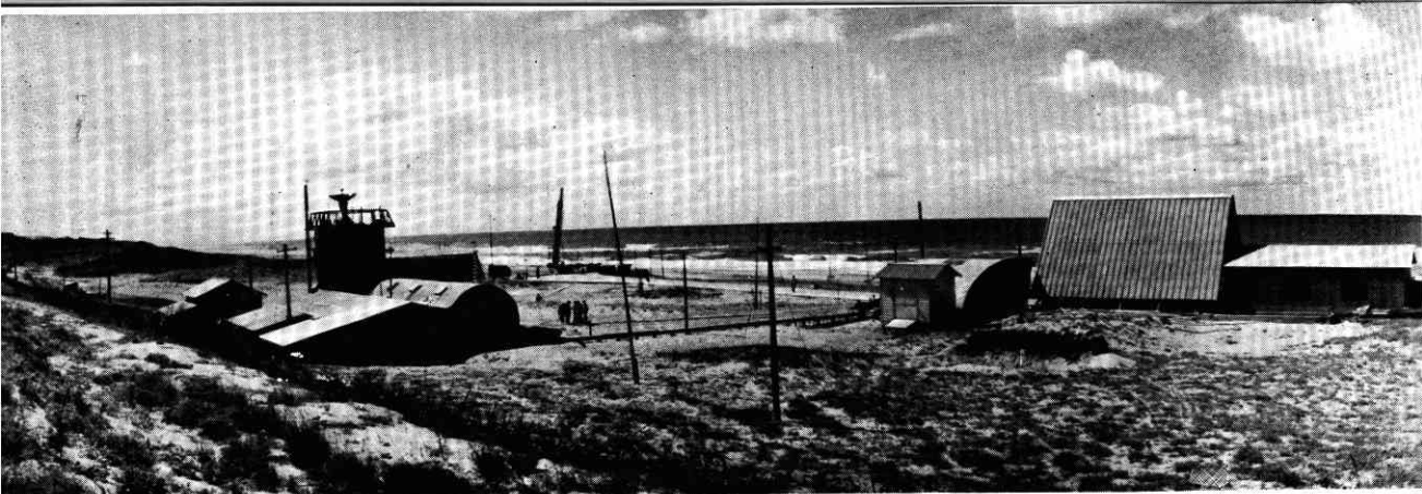
↑ 秋田実験場の全景 (昭和 36 年 7 月)
