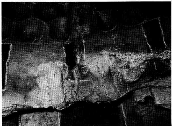
第 9 図 鎌倉大仏後頭部にみられるき裂と鑄掛け
