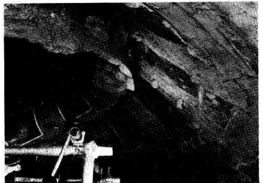
第 18 図 鎌倉大仏頭部サンドブラストによる清浄
