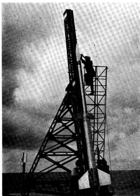
←ランチャー上の K-6 型ロケット スイッチ投入作業中。
