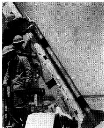
写真3 発音弾とタイマーリード線の結線作業
