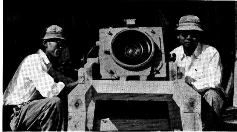
⇩ 北観測点における固定カメラ 200mm レンズ付航空カメラ を正面から見たところ。
