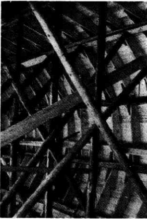
写真 4 計測室屋根仮枠
