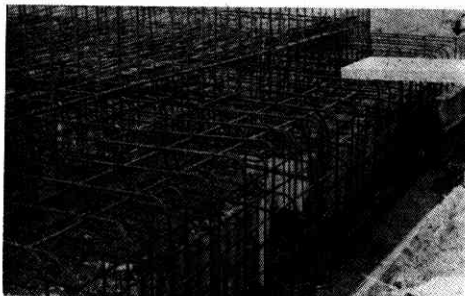
写真1 テストスタンド基礎版の配筋
