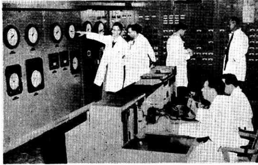
第 4 図 NRX 原子炉の制御室の 1 部
