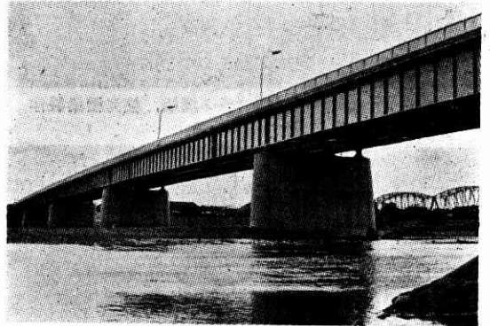
写真3 神奈川県相模大橋 (主桁に高張力鋼 St52 使用, 径間割: 45.6+5@57.76+45.6, 全長 381m, 幅員 9m, 日本鋼管鶴見造船所製作)
