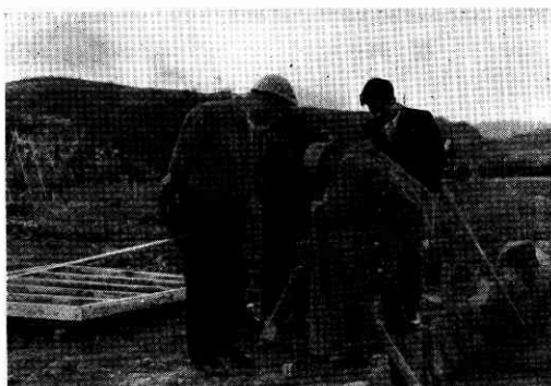
写真-2 基線測量端点の読みとり (先方に 15kg の重りがかけられている)
