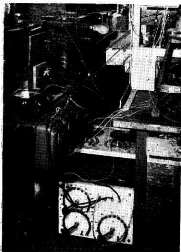
写真1 電気炉電源部
