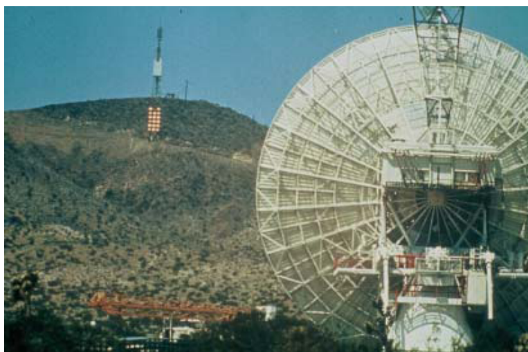
図 1.37 1975 NASA JPL Goldstone でのワイヤレス送電のデモ実験 [31]
