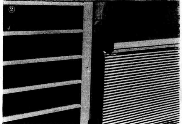
② アルミの窓枠—雨のしみ込みやすい窓臺や框はすつかりアルミで包まれているので、木骨がくさらず永もちする。
