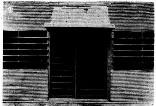
① アルミの家の玄関—壁も庇もアルミづくめで清潔な感じ
