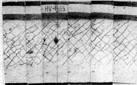
第7圖 實驗Iの單獨縦横配筋壁 ( p_t=0.339 ) の外面破壊状況
