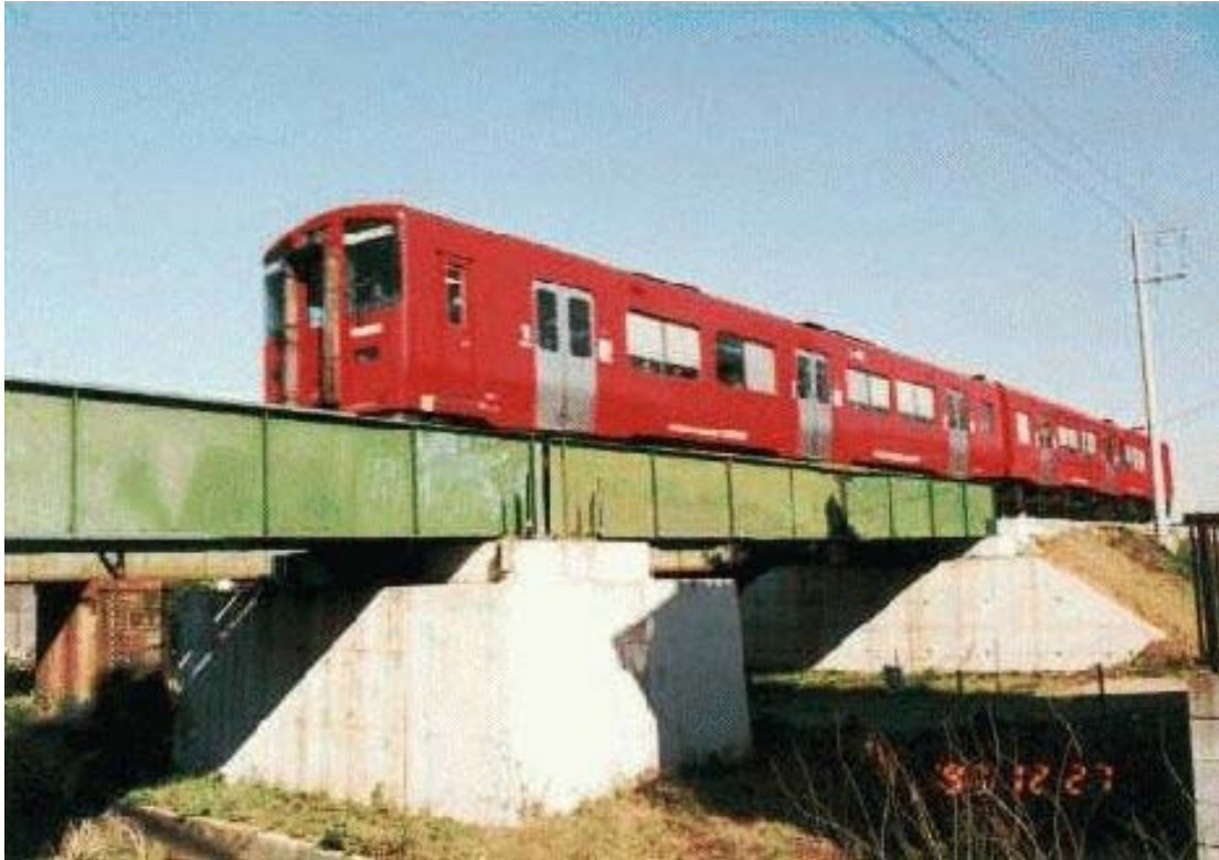
写真 3-5 PL・PS橋脚（P1）の建設（供用開始）
