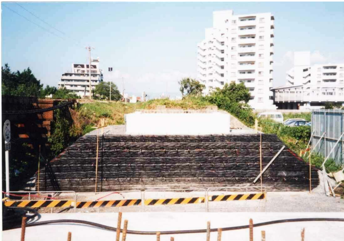
写真 3-6 PL・PS橋台（A2）の建設（RC壁面工打設前）
