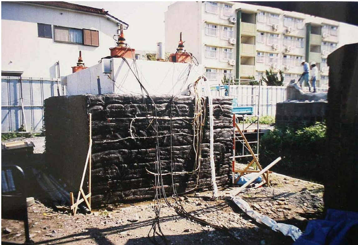
写真 3-4 PL・PS橋脚 (P1) の建設 (プレロード状況)
