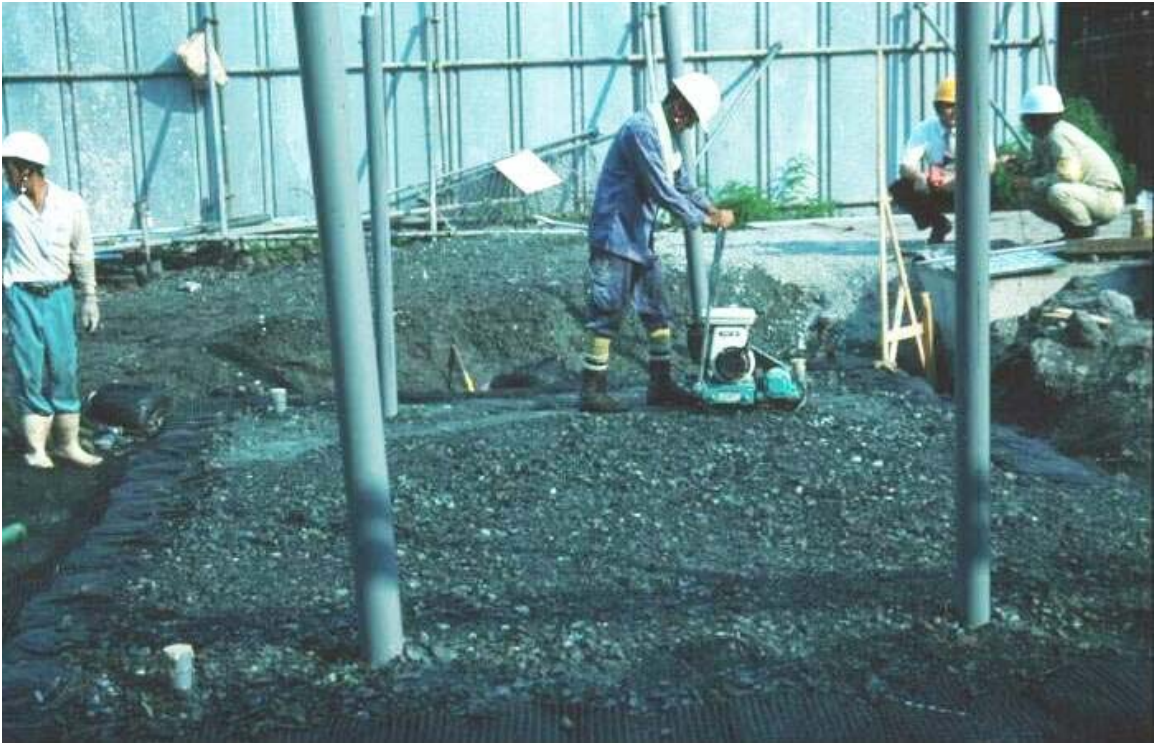
写真 3-3 PL・PS橋脚 (P1) の建設 (締固め状況)
