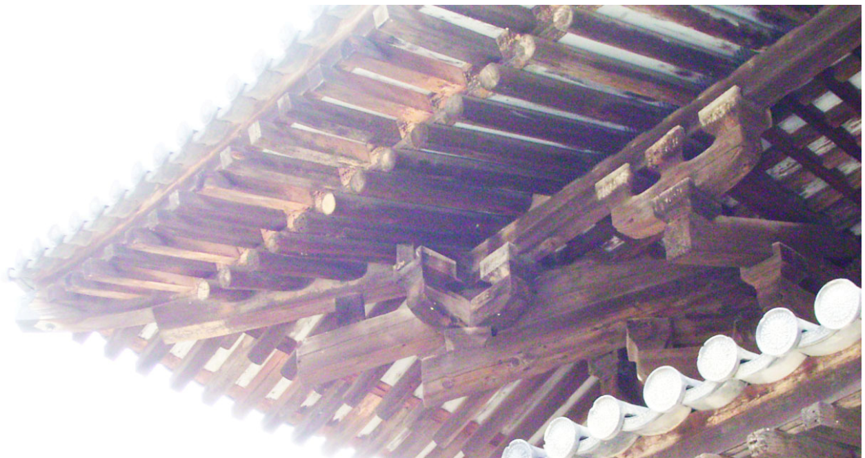
図 3-38 薬師寺東塔 軒先隅部組物
