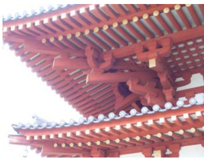
図3-67-1 薬師寺 西塔(隅三組物)
