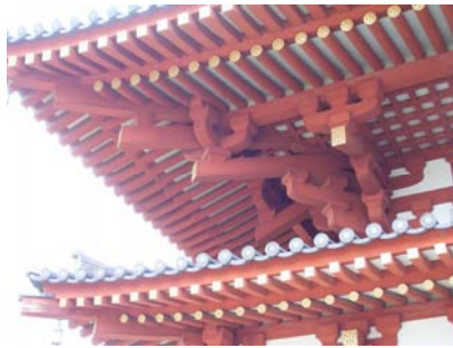
図13-1 薬師寺 西塔(隅三組物)
