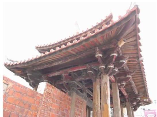
図 3-45-4 龍山寺山門 軒先隅部
