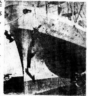
第 15 圖 プレジデントクリーブランド號の船首はフレアがついている。
