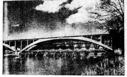
鉄筋コンクリートの新しい形式の橋
