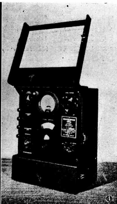
④携帶型測定器；歪計の線の微小 な抵抗變化を眞空管で増巾して、 應力値で讀めるようにしてある。 歪計を多數使用する際はスイッチ を用いて切換えて測る。
