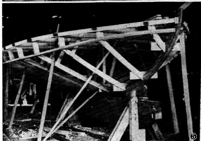
⑤ 建造中の特殊 な高速ヨット。 長さ 5 m で艇 體重量わずか 130kg の豫定。
