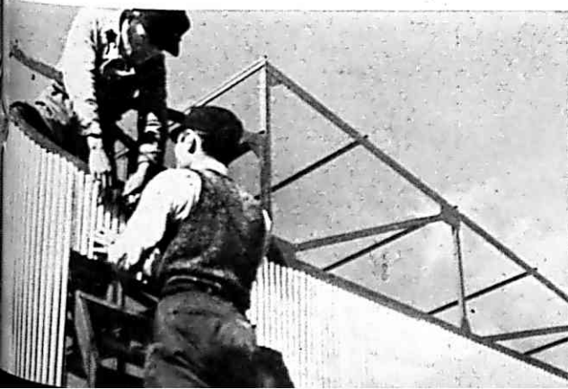
⑦ 外壁の波板の取付け作業、これでだんだん形がととのう。
