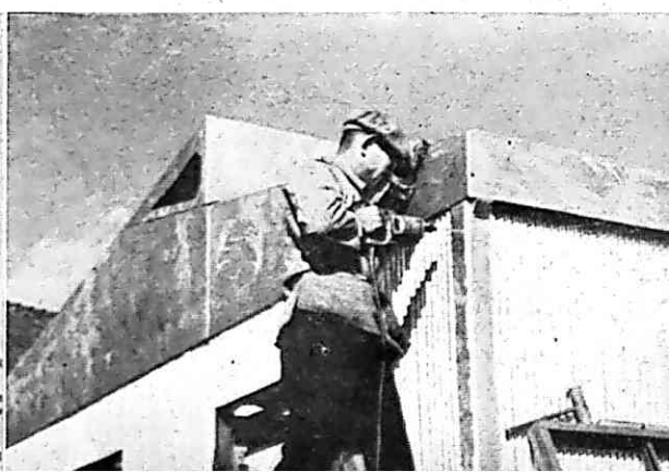
⑧ 日障りな樋は鼻板の中にかくされ樋樋も隅の接合板の中にきれいにつつみこまれてしまう。
