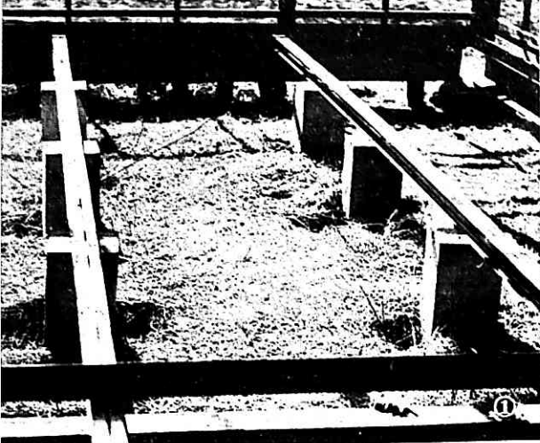
① 基礎の上に並べられた床梁チャンネル。
