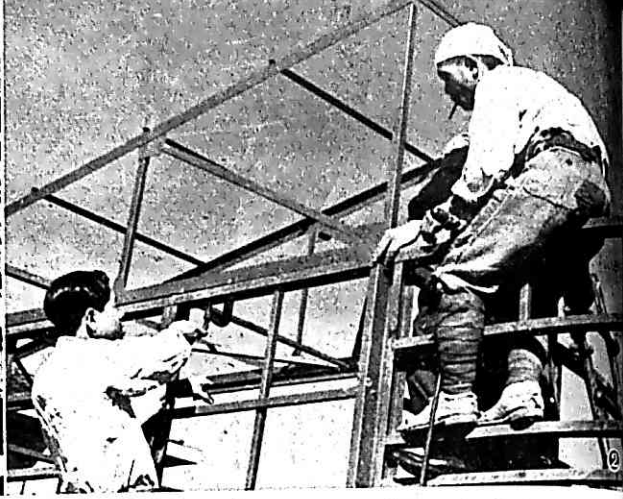
② 工場から運ばれたパネル部品は2, 3人の手で簡単に組立てられる。
