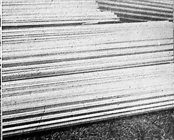
⑥ 屋根や外壁には美しくみがかれた耐蝕性アルミ波板が用いられる。
