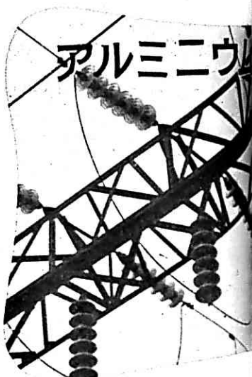
⑧ 受電設備 ↑ 送電線で交流も受け水 整流機で直流になおす。
