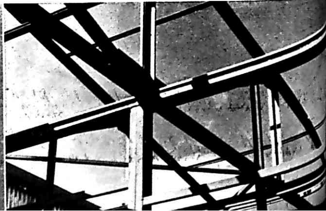
④ 壁パネルと屋根トラスは一體となつて立體的に構成される。
