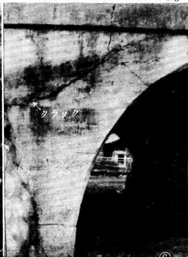
⑥ アーチの被害 石造やコンクリート造でも、一寸した施工上の不注意から寫眞のような被害が起ることがある。
