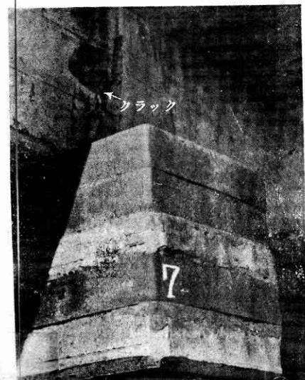
⑱ 宇都宮水道淨水池の震害 上水道の破壊は市民から飲料水と防火用水とをうばう。寫眞は淨水池の石垣に入ったクラック。
