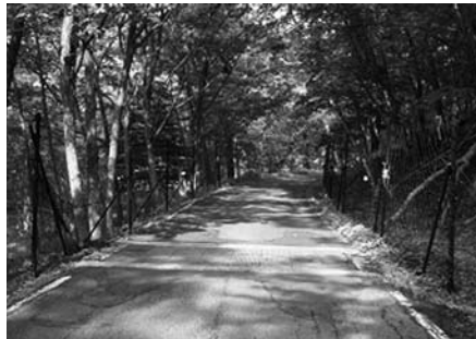
写真4-4 小田代開放部 (グレーチング設置)
