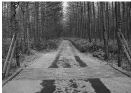
写真4-5 裏男体林道開放部 (グレーチング・超音波装置設置)
