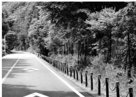
写真 4 - 9 シカ柵の返し（逆川橋開放部の例）
