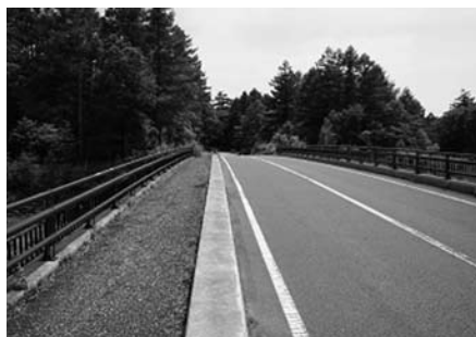
写真4-6 御沢橋開放部 (超音波装置設置)
