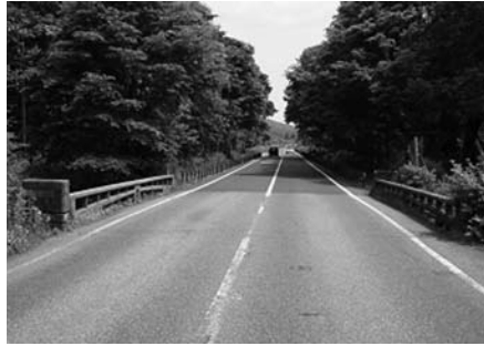
写真 4 - 7 逆川橋開放部（超音波装置設置）
