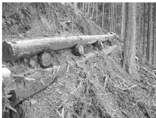
図-4 第2作業道の盛土状況（大橋式路網）
