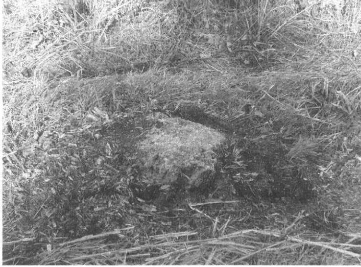
図-2 フレールモアユニットによって粉碎処理された伐根
