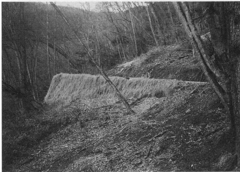
写真-4 高強度プラスチック網（ジオグリッド）による盛土補強工法。 Photo 4. Fill-construction with high quality plastic geo-grids.
