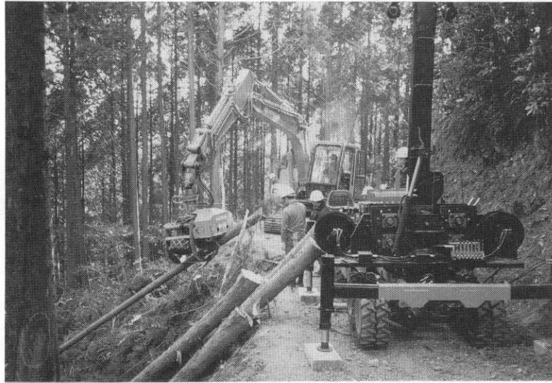
図-6 調査地 B におけるタワーヤーダとプロセッサによる間伐作業.
