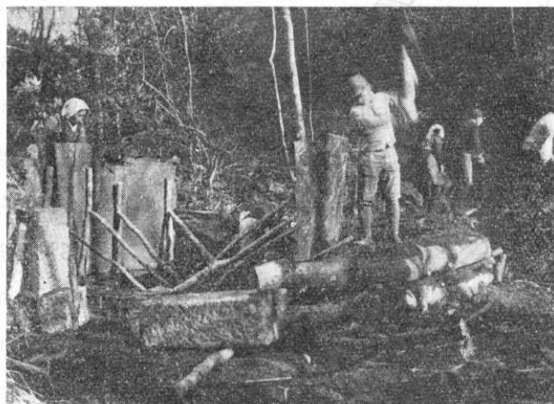
寫眞 4. 農林一號窯—窯壁構築
