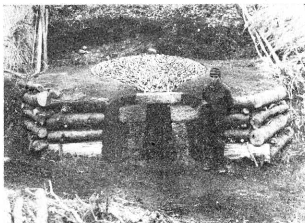
写真 12. 鶴田窯—炭材詰込み・切子盛り (人物は考案者鶴田敏夫氏)
