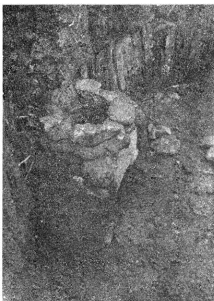
写真 23. 三浦標準黒炭窯—煙道構築
