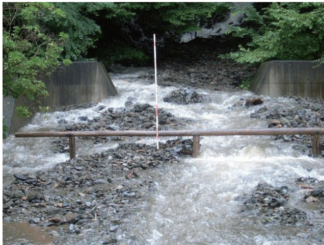
図-3. 2007年9月の台風9号により土石流が生じたバケモノ沢の様子(2007年9月7日栗田直明さん撮影)。図-2にも写っている砂防堰堤が土砂で埋まった様子がわかる。 この台風では、秩父演習林に最も近いアメダス地点「三峯」で、総降雨量544ミリ、最大1時間雨量50ミリを記録した。アメダス地点「三峯」のデータとアメダス確率降雨量計算プログラム(土木研究所水工研究グループ、水理水文チーム作成 http://www.pwri.go.jp/jpn/seika/amedas/top.htm )を用いて計算したこの降雨のリターンピリオド(同じ規模の降雨が、平均して何年に一回の割合で降る可能性があるか)は39年であった。
