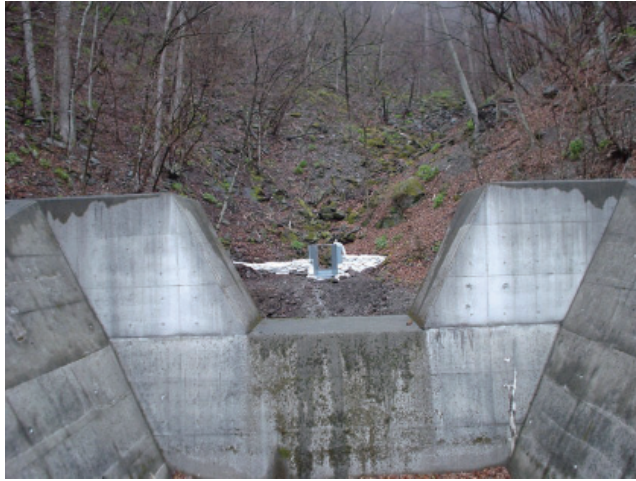
図-2. バケモノ沢に設置されたパーシャルフリューム。手前は砂防堰堤。 (2007年4月23日高野充広さん撮影)
