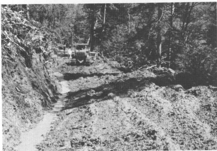
写真-26 ブルドーザーによる整地作業 (1982年6月)
