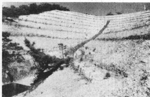
写真12 ガリー(III)侵蝕量測定試験地砂防工事施行後
