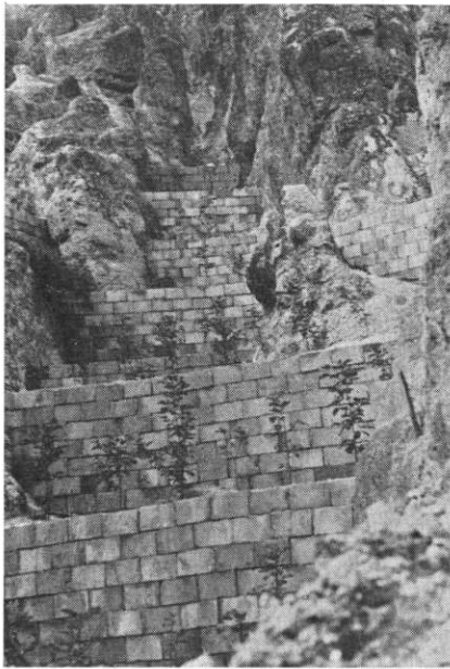
写真 13. 白坂団地：コンクリートブロック工
