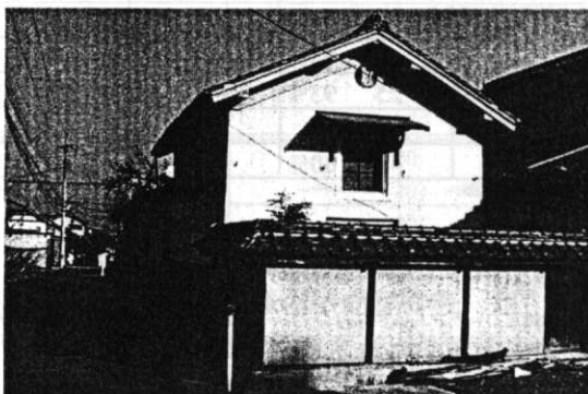
写真5-16 北面沿道の閉鎖空間の連続 -西から見る(上高砂)
