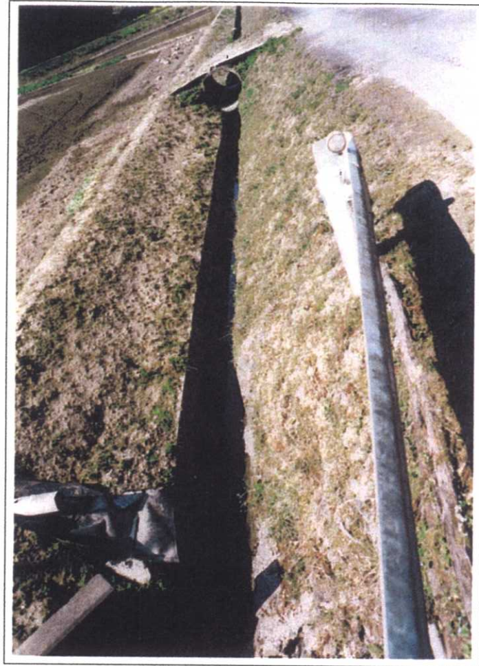
参考写真-11 No. ④の用水路
