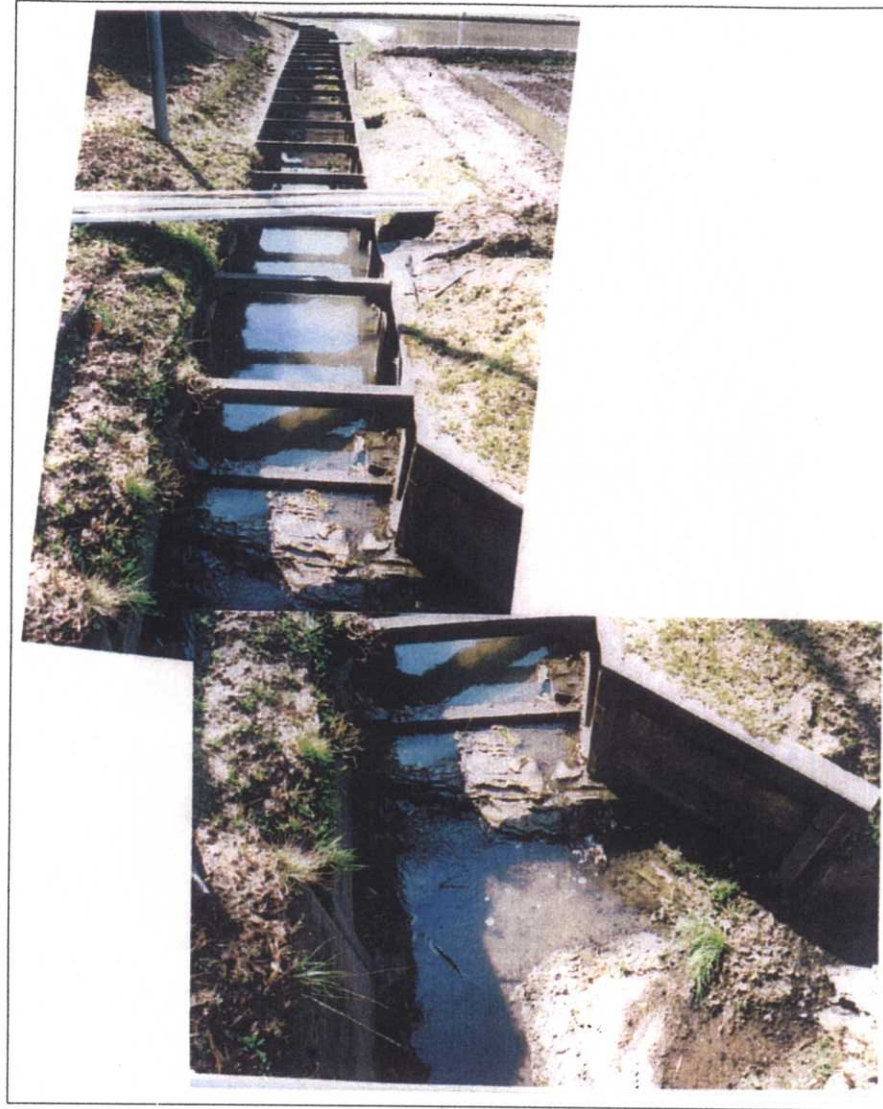
参考写真-10 No. ③の排水路
