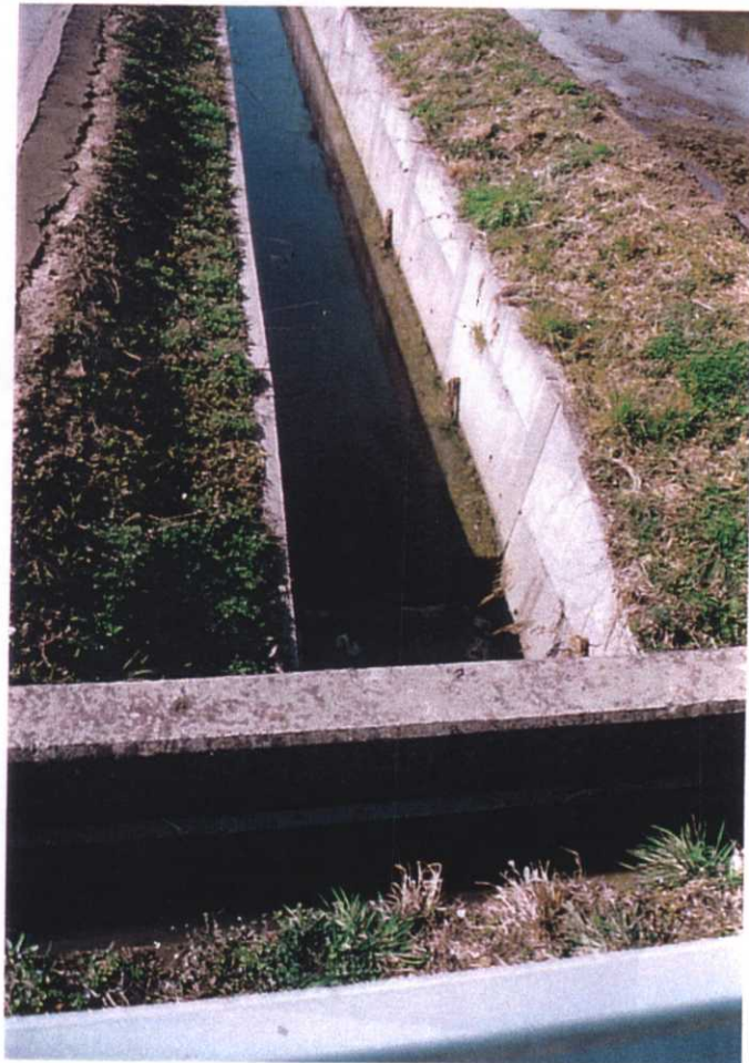
参考写真-8 No. ③の排水路
