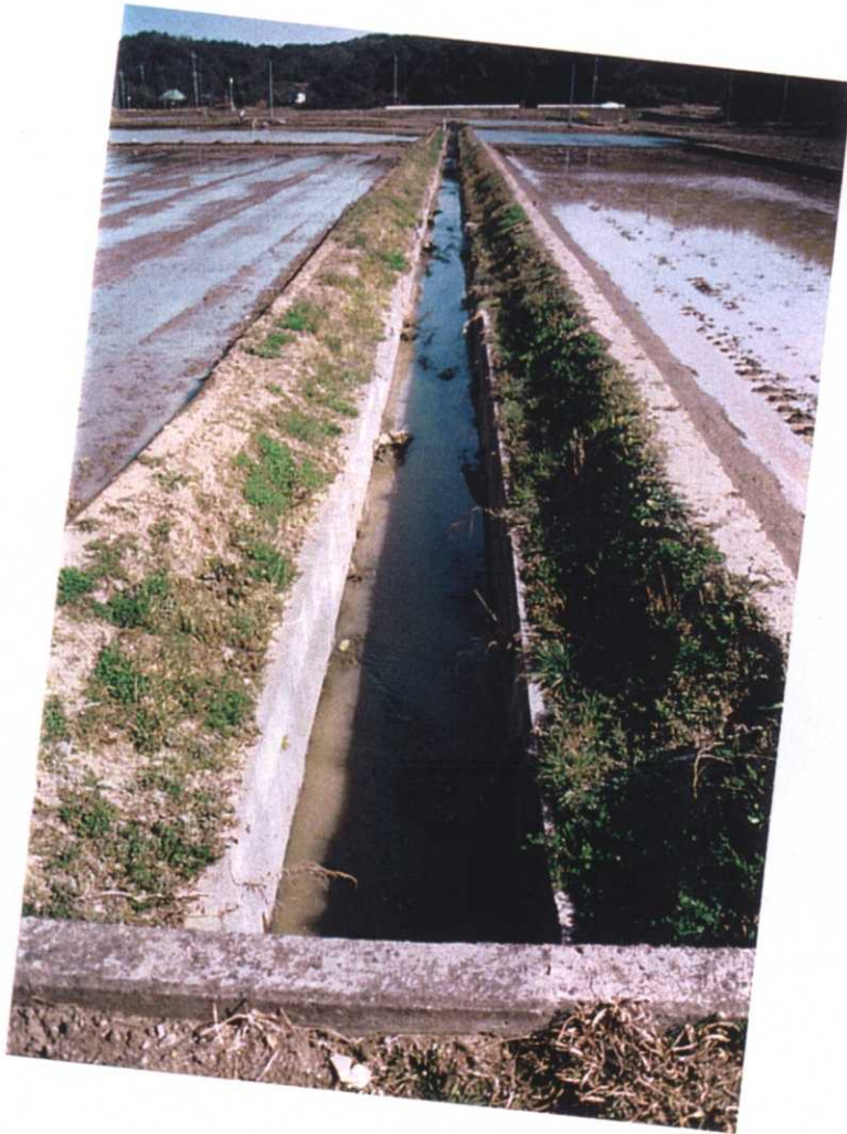
参考写真-9 No. ③の排水路
