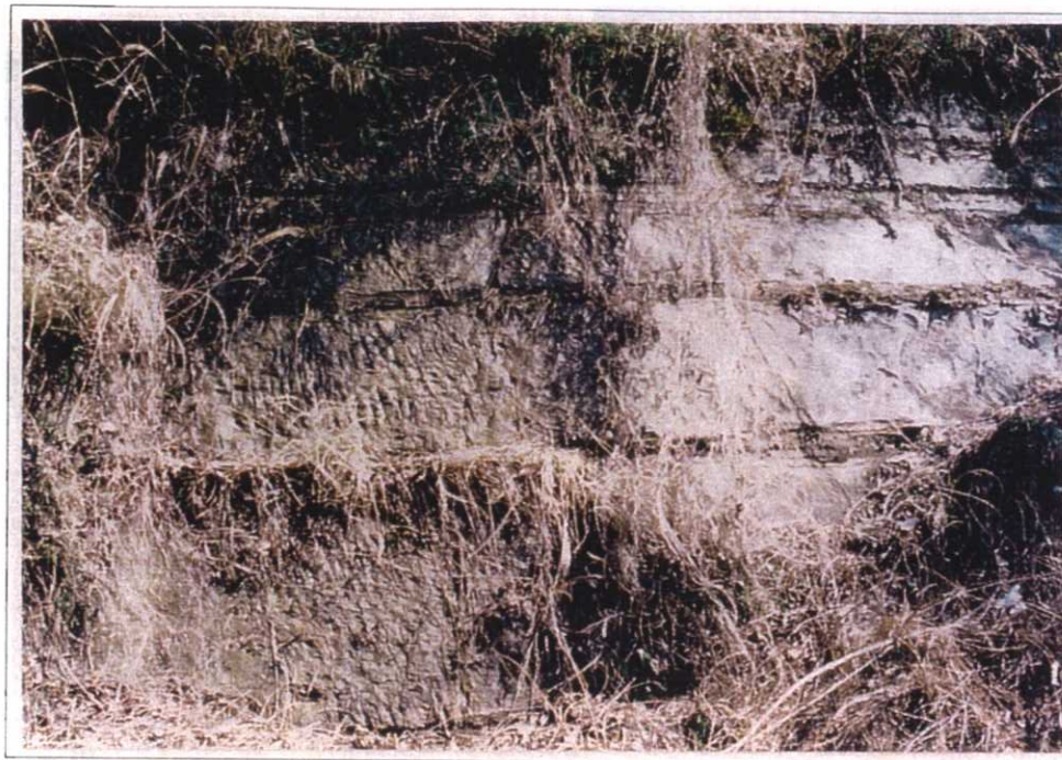
参考写真-2 溜池に出るしみだし水の様子
