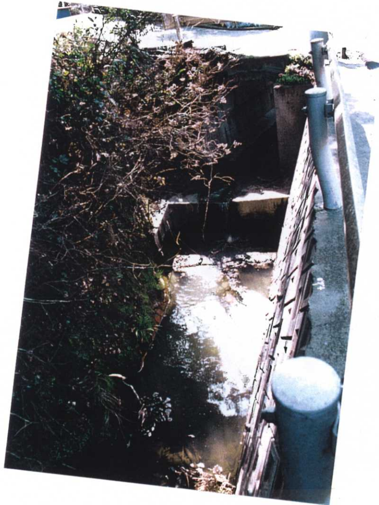
参考写真-7 No. ①自然水路に作られた下流域の段差
