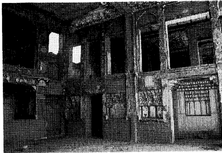
写真12 イマーム・ジョメー邸, 平天井室
