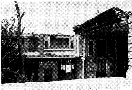
写真11 イマーム・ジョメー邸, 正面外観
