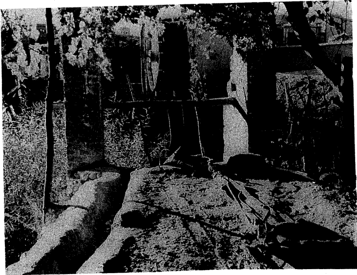
畜力井戸（1滑車）。手前左の溝は灌漑溝、ガーウラーは手前に向っており牛馬がロープを引いて下りる。
