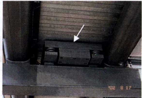
写真 2.2.15 橋の下部に取り付けられた TMD
