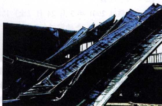
写真 2.2.2 PC 梁屋根の落下
