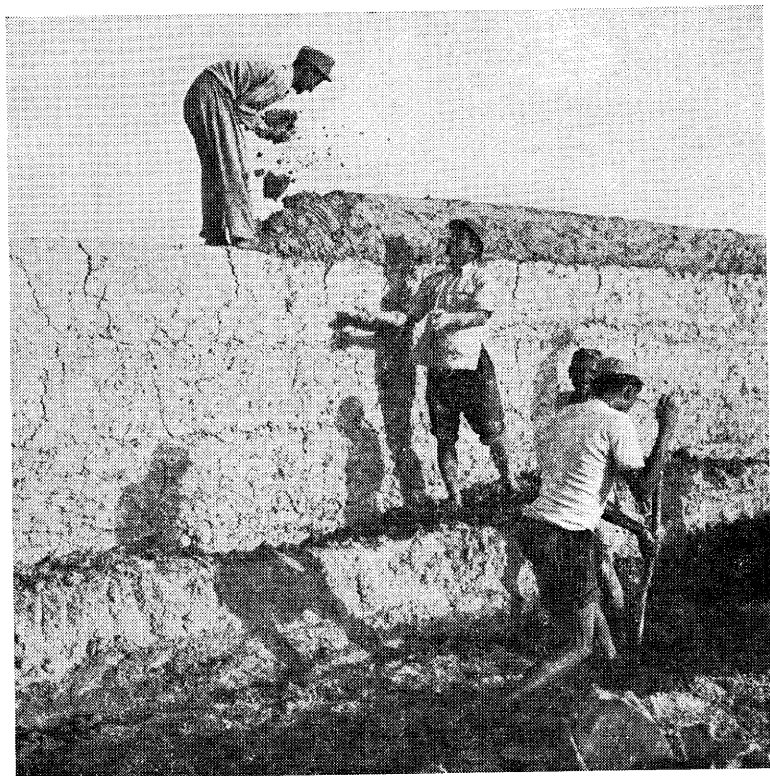
写真9 チネで果樹園の囲壁をつくっている所——イラン南西部ケイルアーバード村 (筆者撮影)
