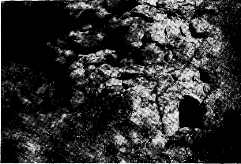
挿圖23 Station Road 堰堤北翼の水門，西側突出部の水道坑。
