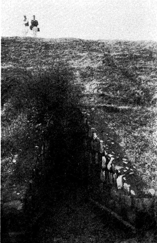
挿圖14 Gadaipur 附近の近代の大堰堤と、その一部に設けられた水門。
