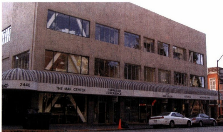
図 2-9 バークレー市内における耐震補強された URM 建物の例
