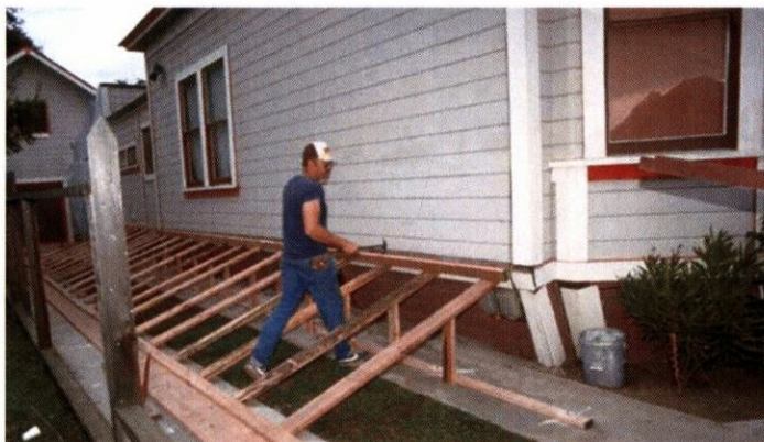
図 2-6 ロマプリエータ地震での Cripple Wall 被害の例
