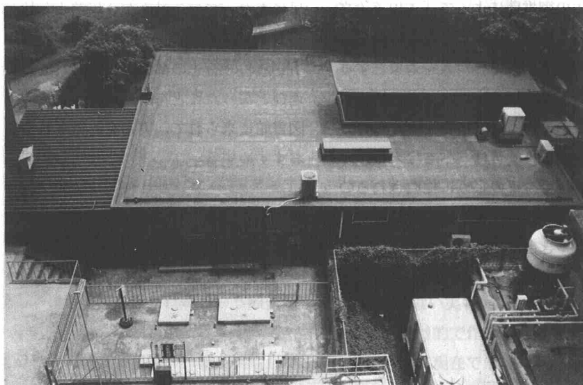
化学新館から望むサブセンター本室の全景
