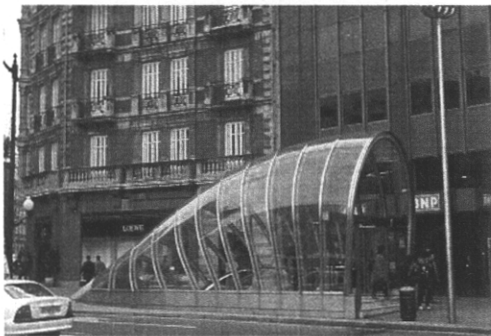
図 7-4 ビルバオ地下鉄の入口
