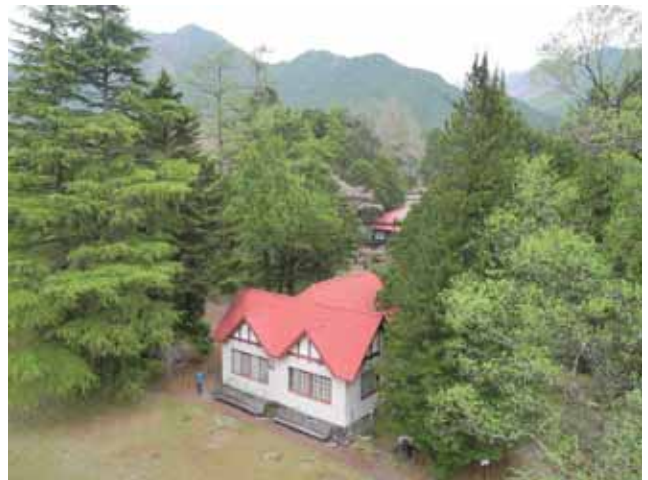
図1：高さ21mのカラマツの木の上から見下ろした日光植物園の実験室と庁舎。本文を読むと、私がこれらの建物についてやせ我慢をしているように思われるかもしれないが、それは違う。本当は、私は赤い屋根の小さな建物たちが大好きで、ずっとこのままでいて欲しいのである。
