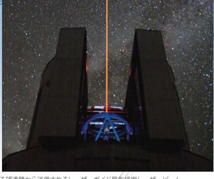
すばる望遠鏡から送信されるレーザーガイド星生成用レーザービーム ~理学の匠「ボケを直す補償光学」より~
